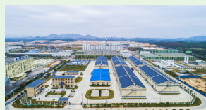
阳西县粮食储备库
